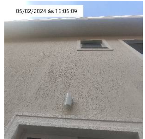
12.6. Parede da casa
