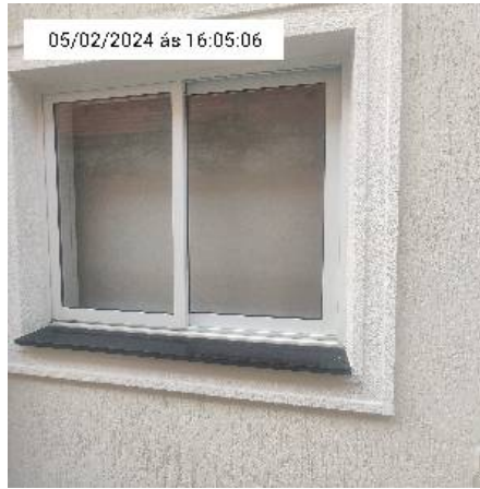
12.6. Parede da casa
