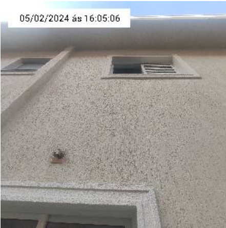
12.6. Parede da casa
