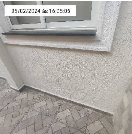
12.6. Parede da casa
