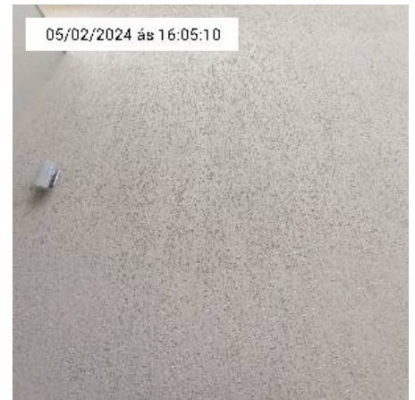
12.6. Parede da casa
