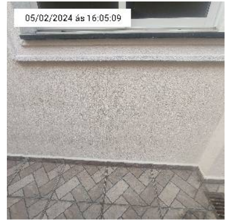
12.6. Parede da casa
