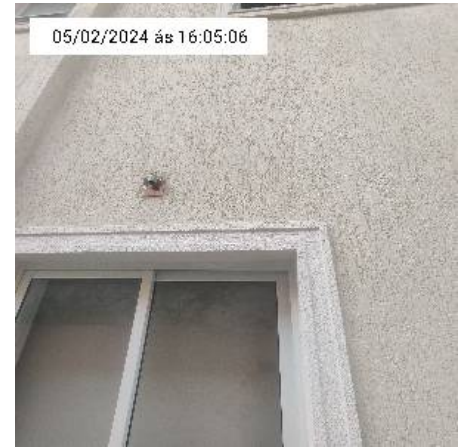
12.6. Parede da casa
