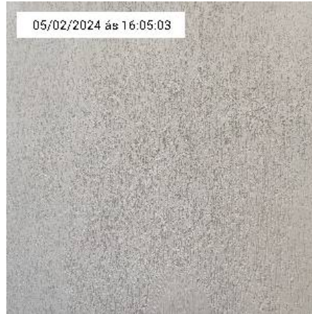
12.6. Parede da casa
