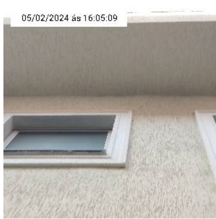
12.6. Parede da casa
