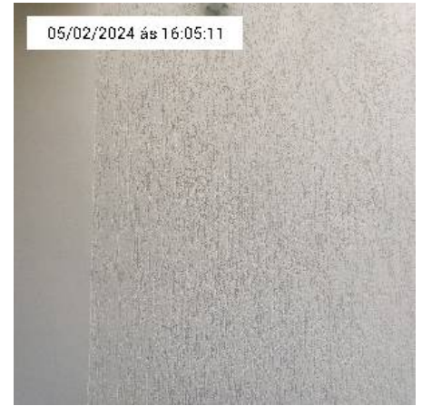
12.6. Parede da casa
