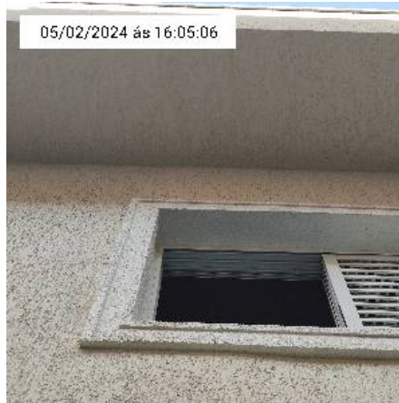
12.6. Parede da casa
