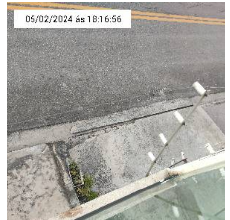
12.2. Central de cerca eletrica/cerca elétrica
