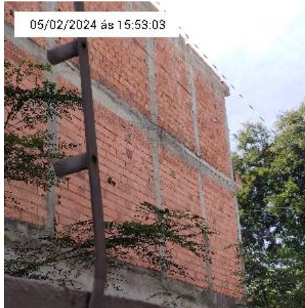
12.2. Central de cerca eletrica/cerca elétrica
