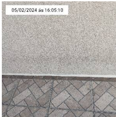
12.6. Parede da casa
