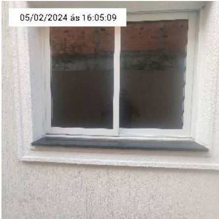
12.6. Parede da casa
