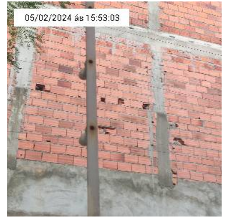
12.2. Central de cerca eletrica/cerca elétrica
