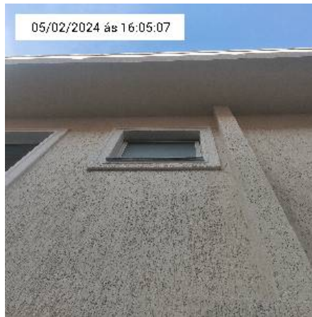
12.6. Parede da casa
