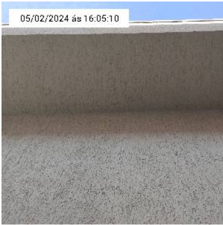
12.6. Parede da casa
