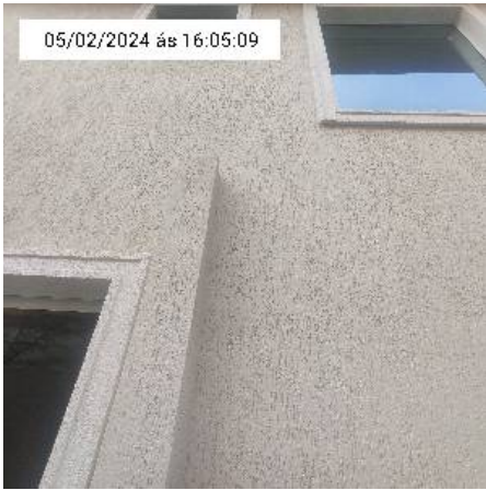
12.6. Parede da casa
