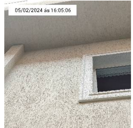
12.6. Parede da casa
