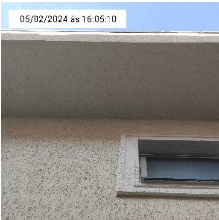
12.6. Parede da casa
