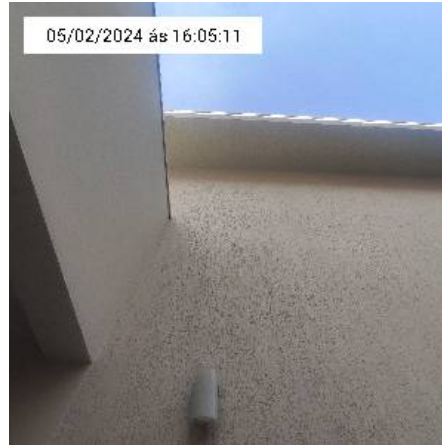
12.6. Parede da casa
