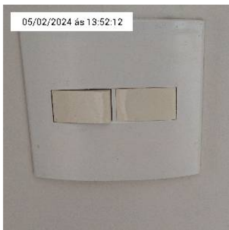
7.4. Tomadas e Interruptores
