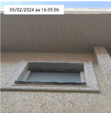
12.6. Parede da casa
