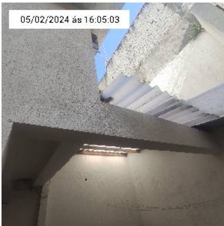
12.6. Parede da casa
