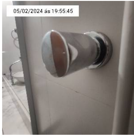
11.13. Registro de água
