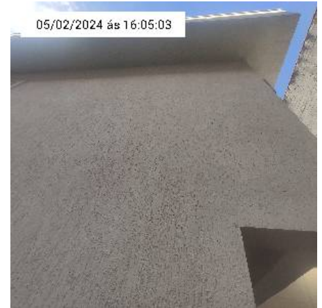
12.6. Parede da casa
