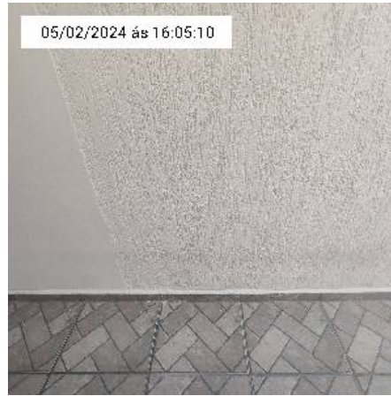
12.6. Parede da casa
