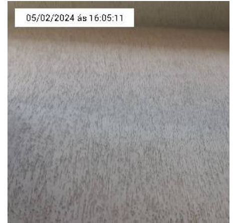
12.6. Parede da casa
