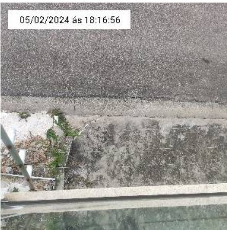
12.2. Central de cerca eletrica/cerca elétrica
