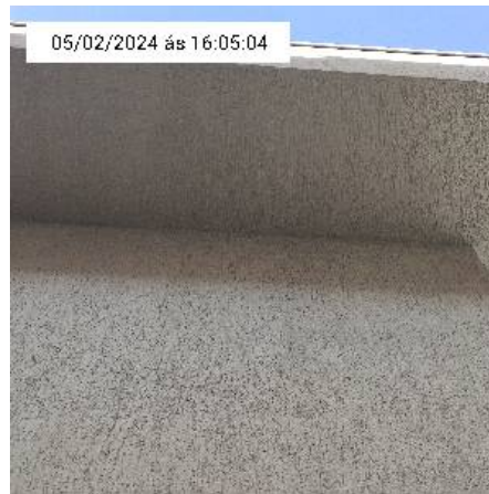
12.6. Parede da casa
