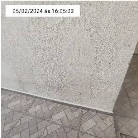
12.6. Parede da casa
