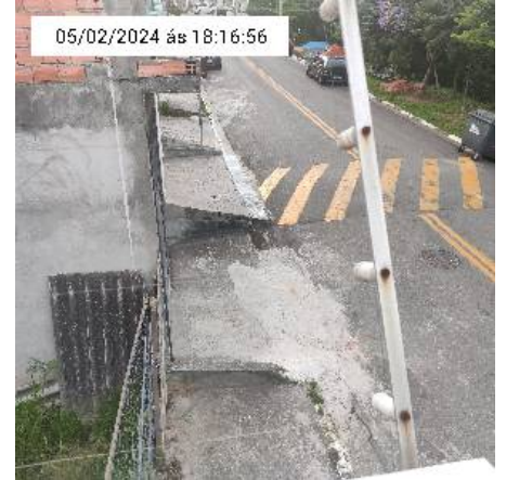
12.2. Central de cerca eletrica/cerca elétrica
