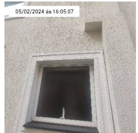
12.6. Parede da casa
