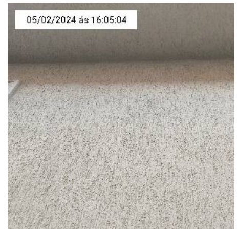
12.6. Parede da casa
